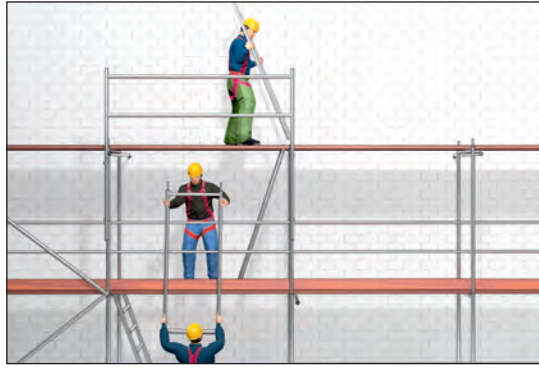
Abb. 6, 7 und 8: Ablauf der Gerüstmontage unter Verwendung des MSGs und PSaGA
