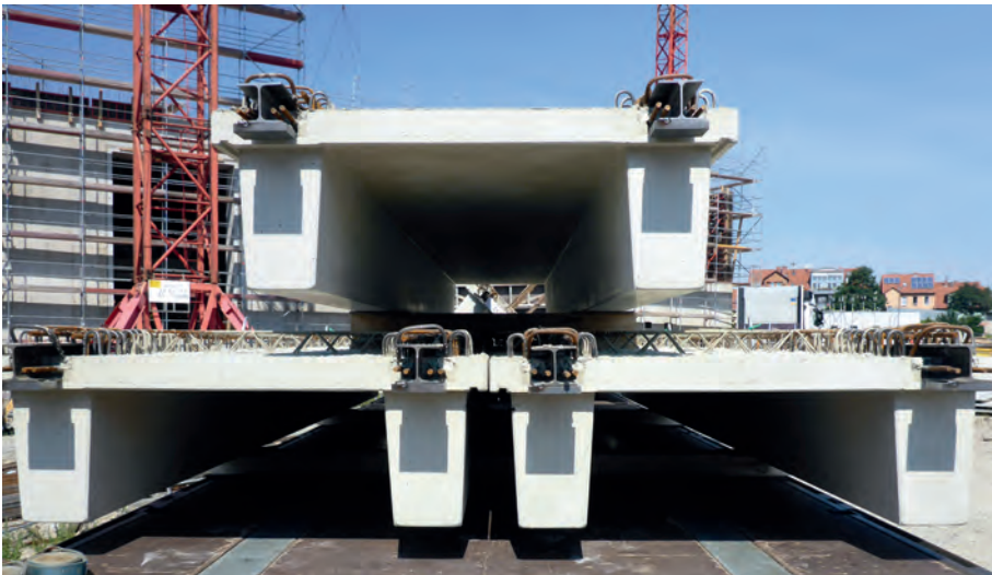
Abb. 7: 270 von diesen bis zu 6 t schweren II-Platten wurden für die Rippendecken benötigt (Foto: ARGE Tragwerksplanung Bauhausmuseum Weimar)
