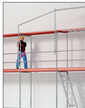
Abb. 4 und 5: Montage MSG (links) und Montage im Schutz des MSG (rechts)
