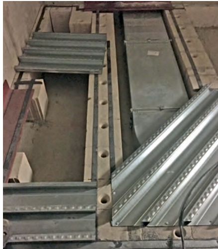
Abb. 13: Aufbau Holoribdecke mit Holoribblechen (Foto: Matthias Jopke)
