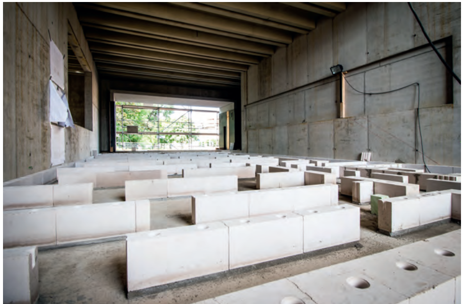
Abb. 12: Mauerwerksauflager (Foto: Matthias Jopke)
