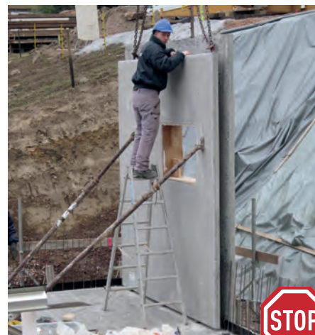
Abb. 4: Fehlanwendung durch Wahl einer ungeeigneten zu kurzen Leiter (Quelle: BG BAU, J. Maringer)
