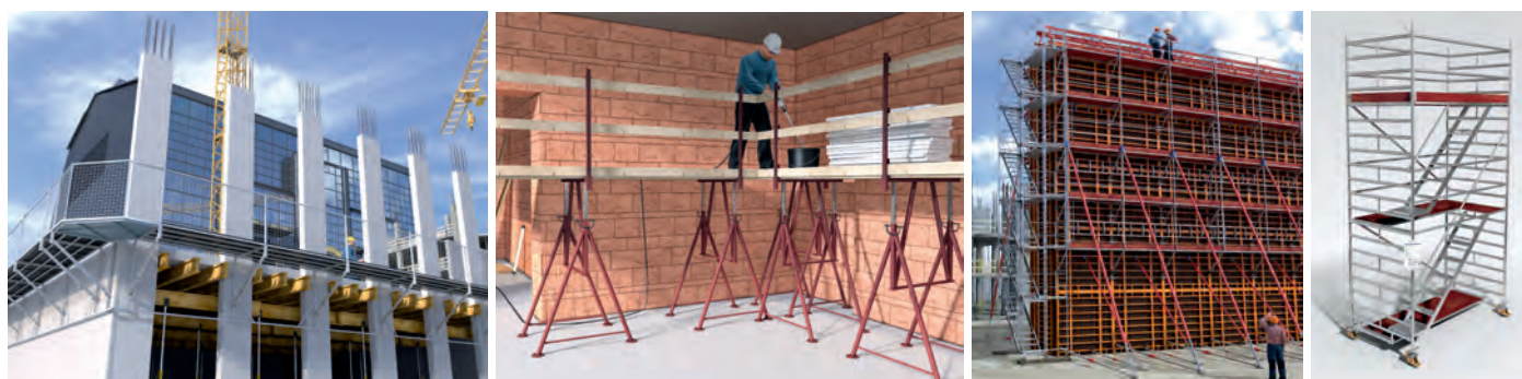
Abb. 1: Konsolgerüste, Bockgerüste, Schalungen, Traggerüste und fahrbare Arbeitsbühnen unterliegen nicht mehr dem TRBS-Teil „Gerüste“
