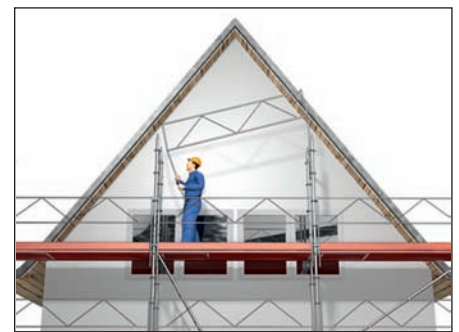
Abb. 2 und 3: Montage systembedingt vorlaufender Geländer
