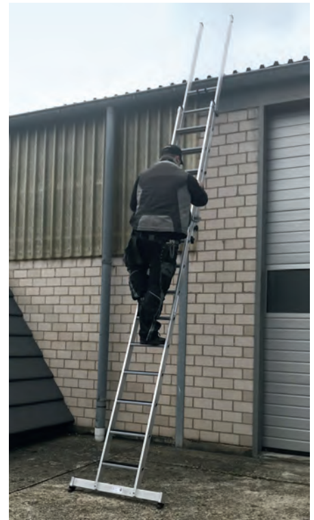
Abb. 6: Prototyp einer Stufenanlegeleiter, die derzeit von mehreren Herstellern mit Unterstützung der BG BAU entwickelt werden (Quelle: J. Maringer, BG BAU)
