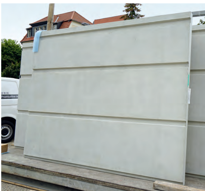
Abb. 4: Fassadenelemente aus hochwertigem Sichtbeton (Foto: Bärbel Rechenbach)
